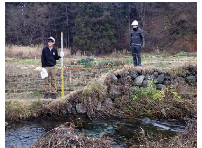
長野県北部の地震(2014年11月22日)で生じた地表断層。元々平坦な畑だったが、右手側が逆断層運動により約85cm相対的に隆起した。
